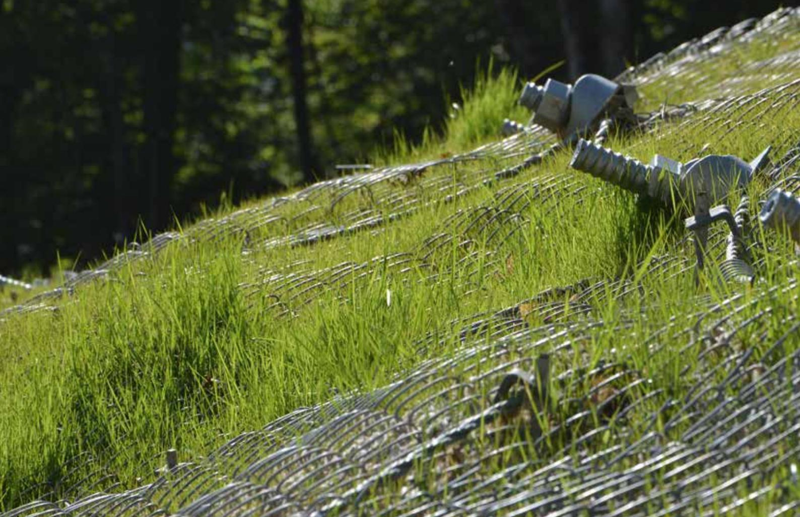
Основные элементы системы **MIGHTYNET**, эластичная стальная сеть и гибкий стальной канат, отлично повторяют особенности рельефа и закрепляют склоны со сложной поверхностью.
