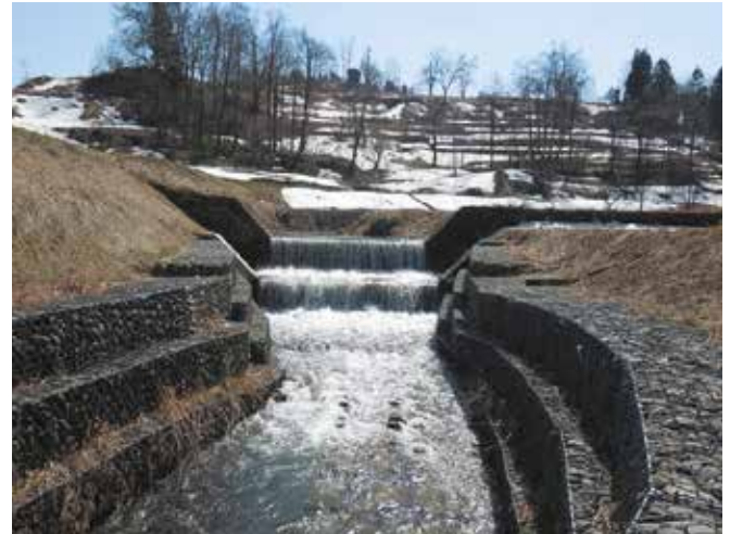
Рис. 5. Инженерная защита на р. Нишитани Гава с применением габионов RockBox
