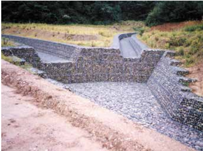
Рис. 4. Инженерная защита на р. Нишитани Гава с применением габионов RockBox
