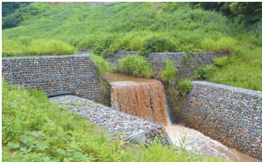
Рис. 3. Объект с габийными конструкциями RockBox в Японии
