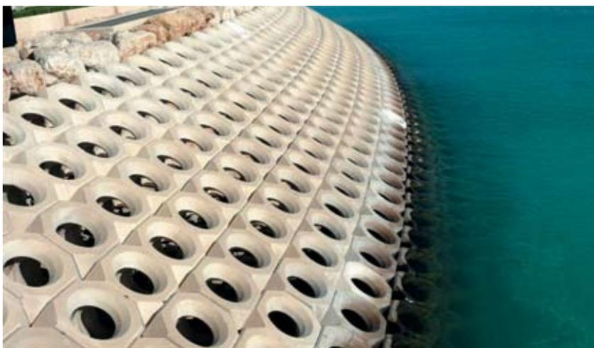
Рис. 12. Берегоукрепление намывных островов (Дубай) пустотелыми бетонными блоками
