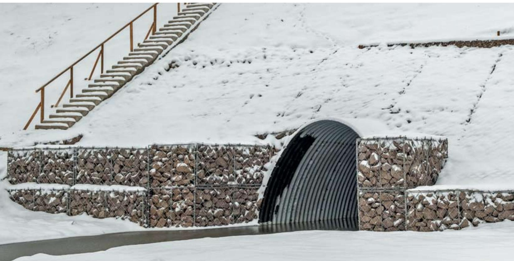
В статье приведены конструктивные особенности высокопрочных габионных конструкций RockVox. Представлены конструкции водопропускных и водопереливных плотин, приведено обоснование подбора камня-заполнителя в зависимости от требуемого коэффициента фильтрации. Изложены проблемы размыва дна в нижнем бьефе водосливных плотин и у причалов, а также размыва берегов и пути их решения с помощью габионов RockVox. Приведены конструкции береговых навигационных знаков из высокопрочных габионов RockVox.
