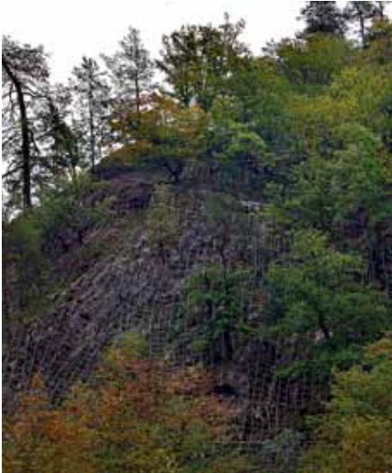
Рис. 18. RopeNet. Укрепление скального массива на объектах в Красной Поляне
